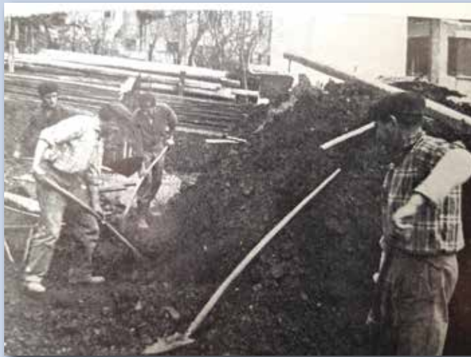
“1961: si inizia a scavare”
