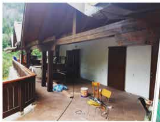
Val Daone: campo medie e lavori di ristrutturazione della casa
